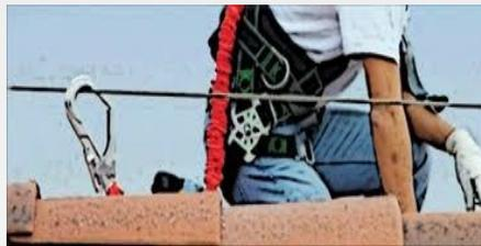
Le linee vita possono essere sia temporanee che stabili: nel primo caso sono utilizzate per il montaggio di prefabbricati e, una volta terminato il lavoro, vengono smontate; nel secondo caso, invece, sono installate in modo permanente sulle coperture degli edifici e utilizzate ogni qualvolta si debba procedere a opere di manutenzione.
