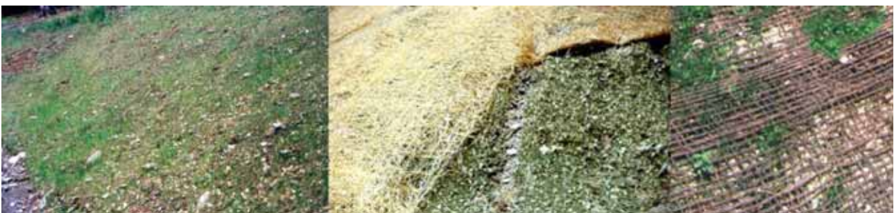
Fig.3.16 – Semine normale, con biostuoia in cocco e paglia, con biotessile in juta
