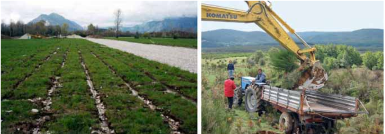
Fig.3.24 – Prelievo e messa a dimora di "ecocelle"
