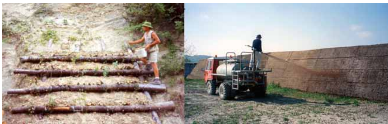
Fig.3.17 – Semina a spaglio e idrosemina
