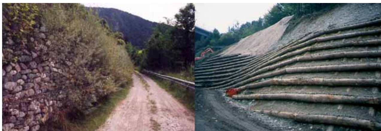
Fig.3.19 – Gabbionate rinverdite e Grate vive
