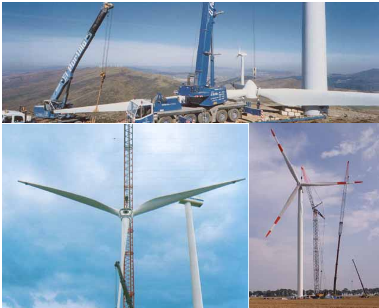
Fig.3.5 – Sollevamento e montaggio del rotore
