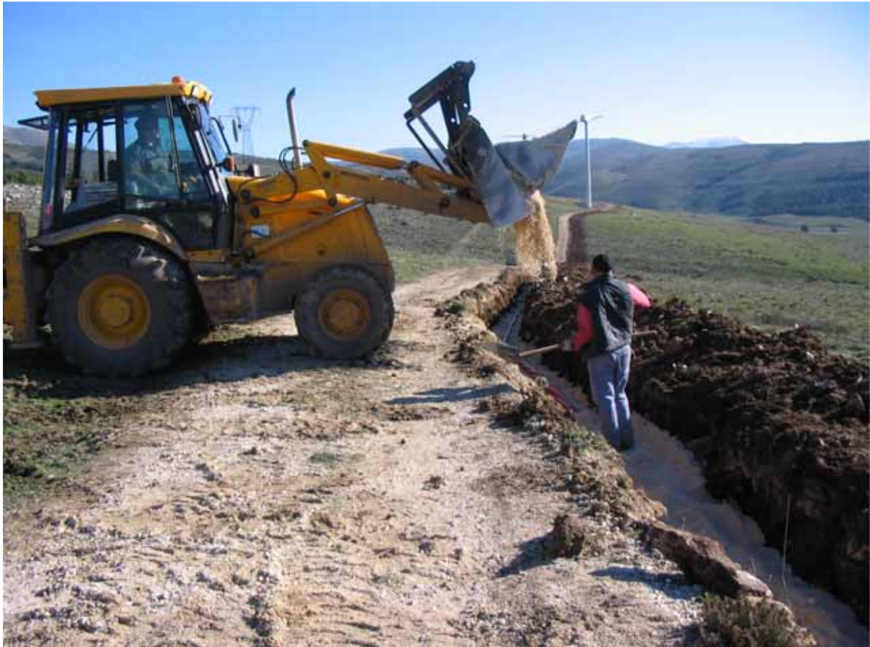
Fig.3.6 – Lavori di scavo per l'alloggio dei cavi
