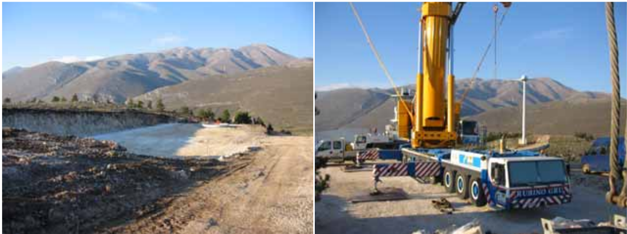
Fig. 3.3 – Piazzole e gru per il montaggio degli aerogeneratori
