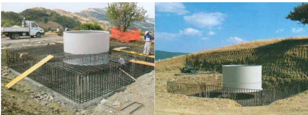
Fig. 3.4 – Fondazioni degli aerogeneratori
