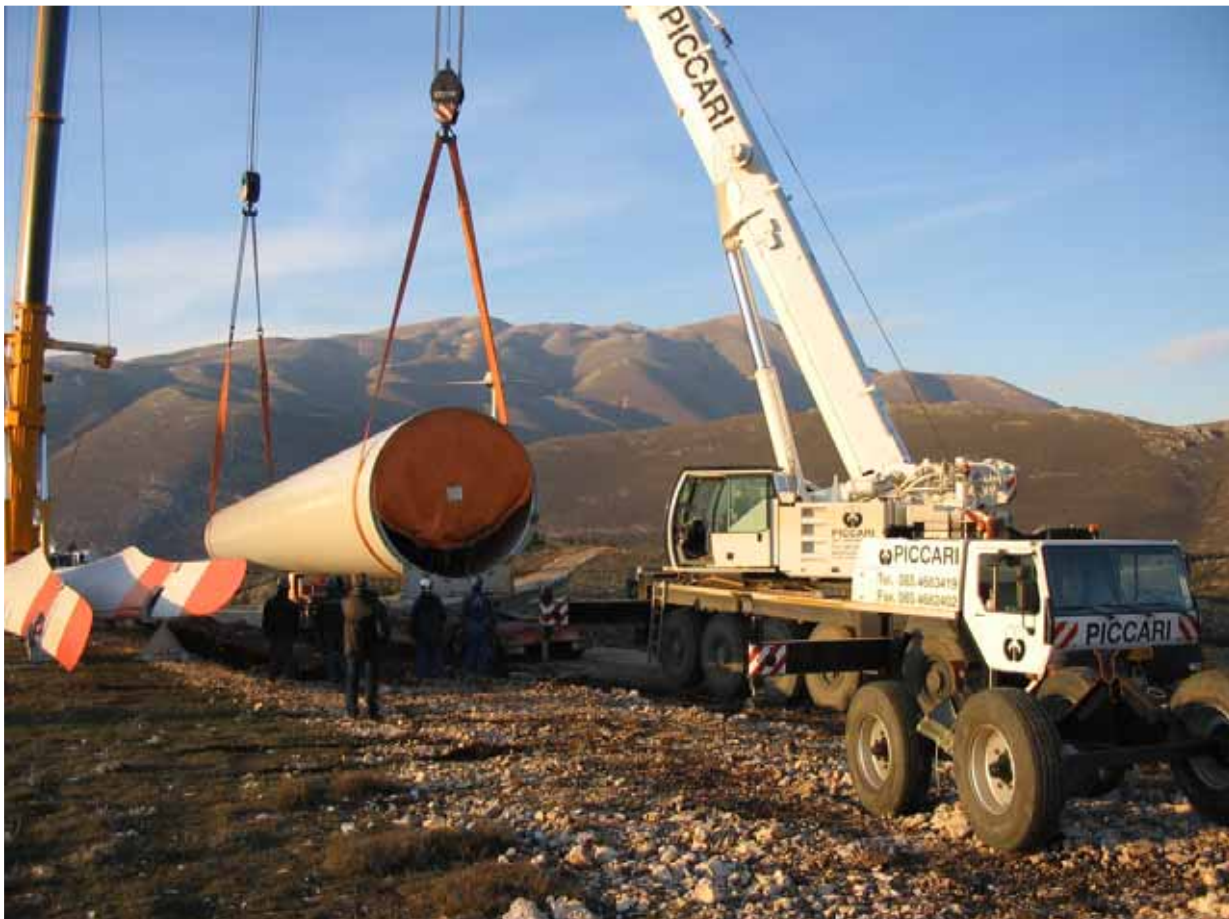
Fig. 3.9 – Operazioni di sollevamento di un concio di torre
