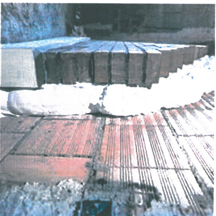
INSUFFLAGGIO DI SCHIUMA DI POLIURETANO
